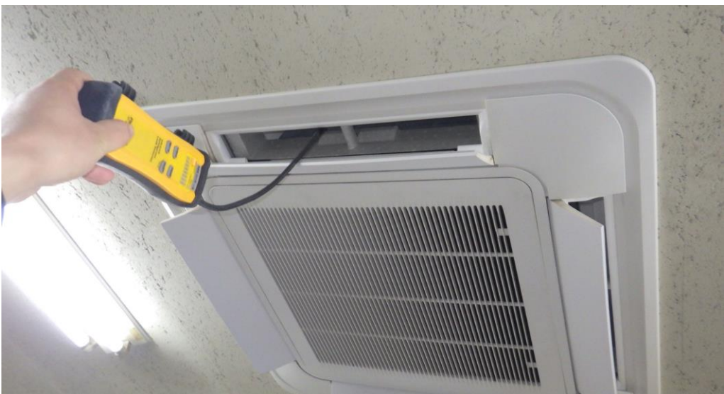
空調機点検の様子
