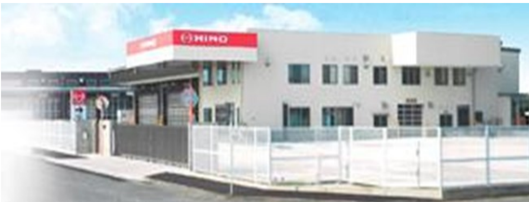
田富竣工写真
