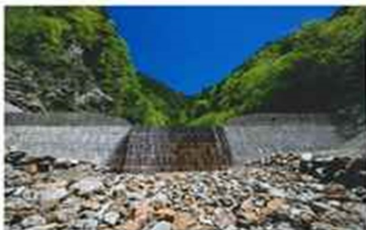
治山工事(林野庁)-間伐材を利用した治山堰堤
