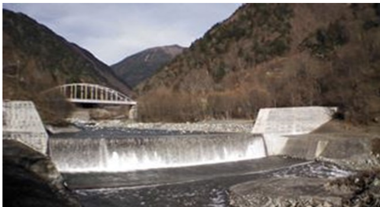
砂防工事(国交省)-砂防堰堤
