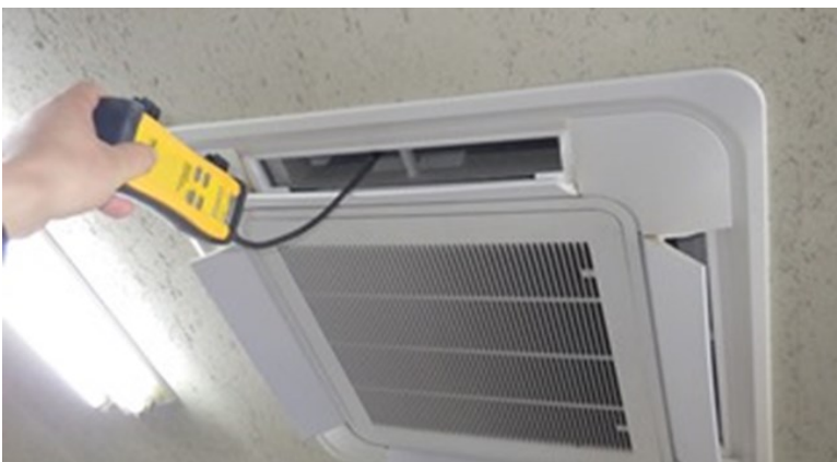
空調機点検の様子
