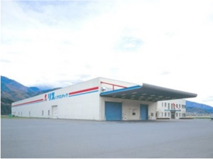
山梨工場外観
