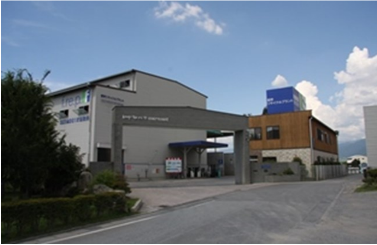
本社プラント入口
