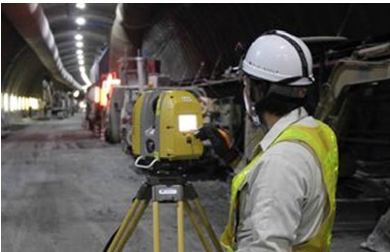
トンネル坑内で3Dスキャナー計測
