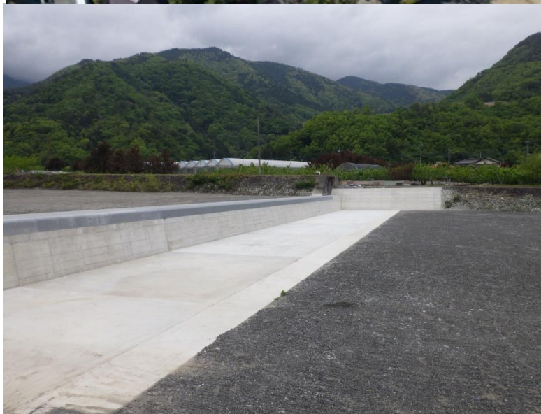
R2 御勅使川砂防工事
