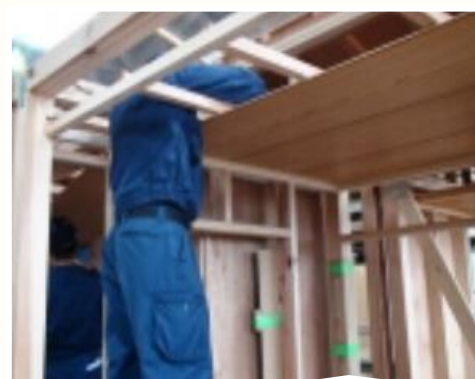
天井施工実習
