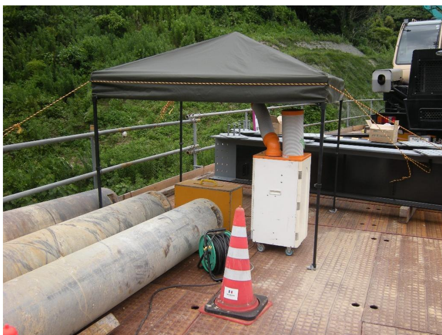
熱中症対策：仮設の休憩所
