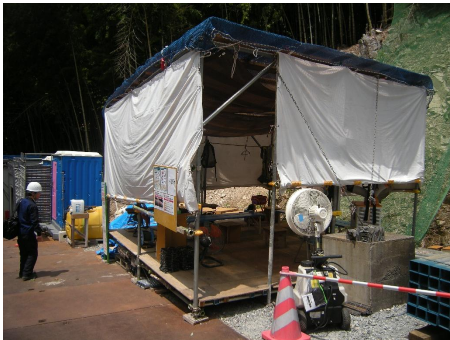
熱中症対策：仮設の休憩所
