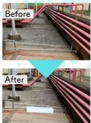
配管のオーバーデッキ設置事例
