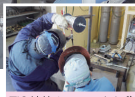
TIG 溶接 (ステンパイプ)
