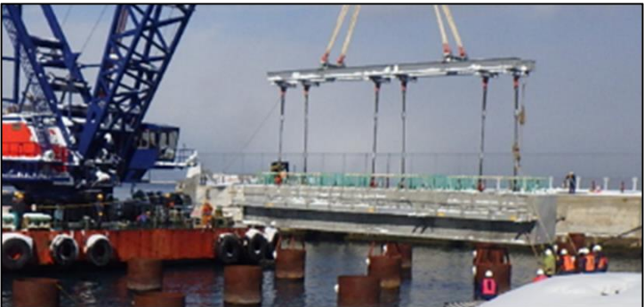
プレキャスト部材を用いた栈橋上部工の施工 (潮待ち等によらず昼間作業が可能)
