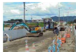
道路築造工事の土工作業風景
