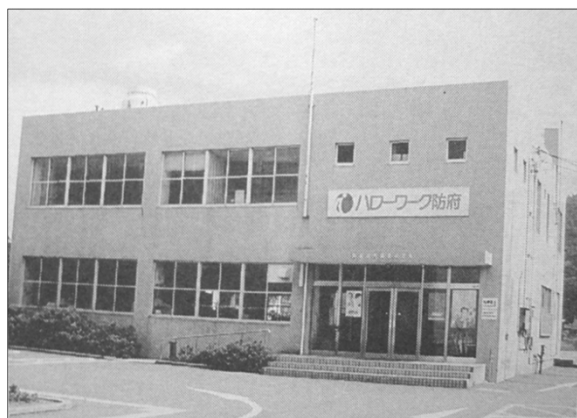
現庁舎(昭和47年3月～)
