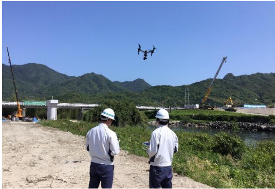
ドローンによる効率的な測量
