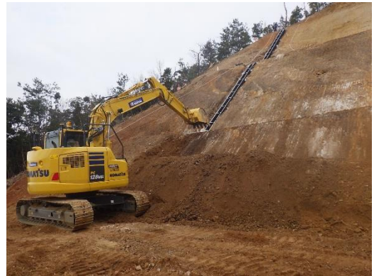
丁張りを設けることなく、日々の掘削を実現
