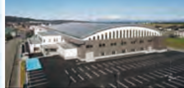
鶴岡市だだちゃアリーナ新築工事
