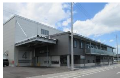
▲内山電機工業株式会社 社屋
