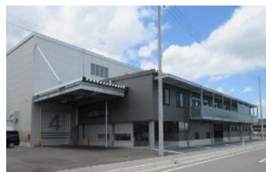
▲内山電機工業株式会社 社屋
