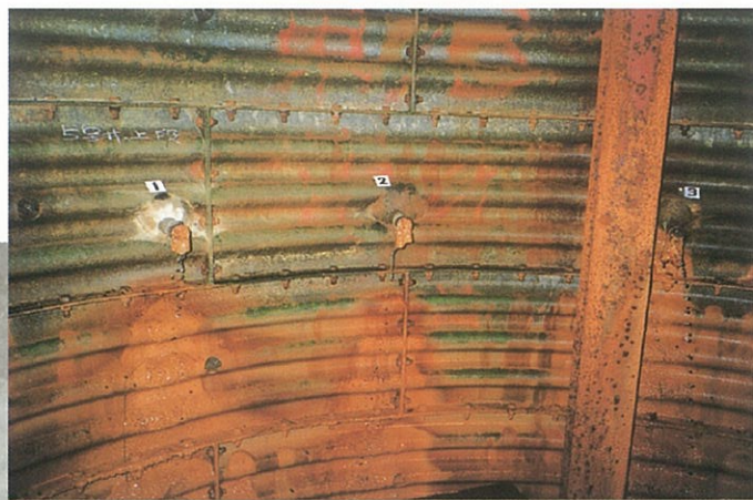
■超高压水洗净工（施工前）
