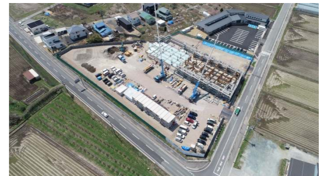
⑦ (令和4年4月中旬) 1階床・1階躯体工事 施工中
