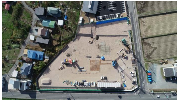
② (令和3年11月上旬) 杭地業工事 杭埋設施工中
