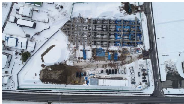
④ (令和4年1月下旬) 基礎工事 施工中
