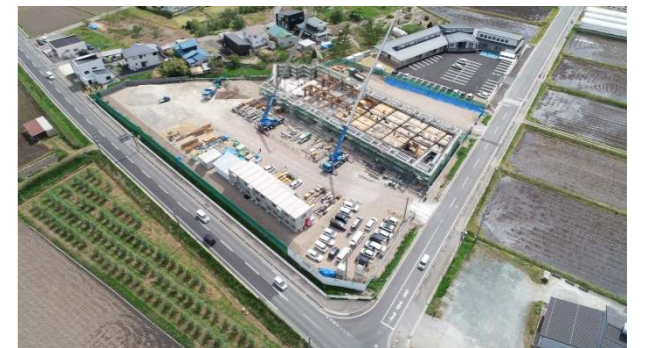
⑦ (令和4年4月中旬) 1階床・1階躯体工事 施工中
