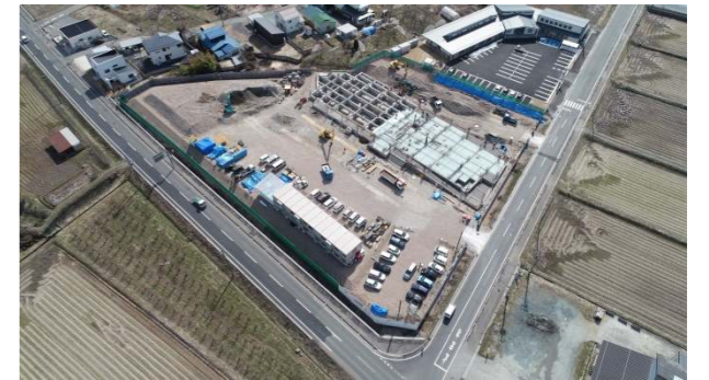
⑥ (令和4年3月下旬) ピット土間・1階床工事 施工中
