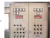
浄化センター
