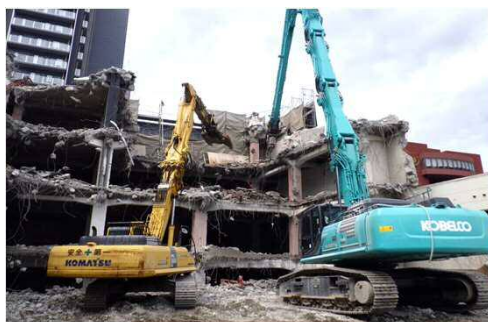
RC造6階建ビル 解体工事
