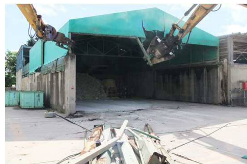
テント倉庫 解体工事
