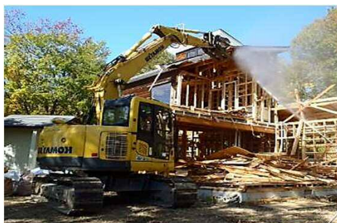
木造一般住宅 解体工事
