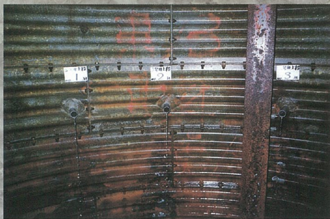
■超高压水洗净工（施工後）
