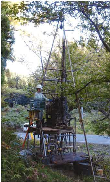
ボーリング調査
