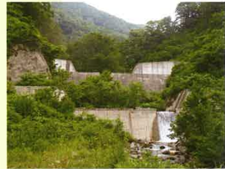
砂防施設点検
