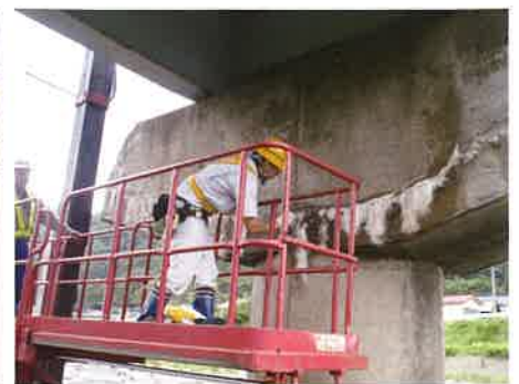
橋脚詳細調査
