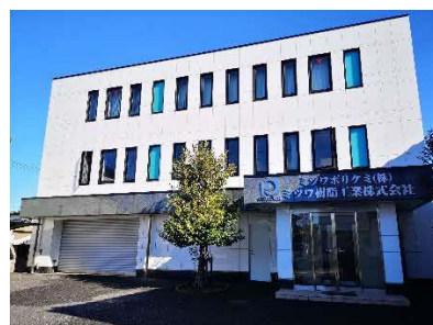
埼玉県川口市本社社屋
