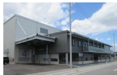
▲内山電機工業株式会社 社屋
