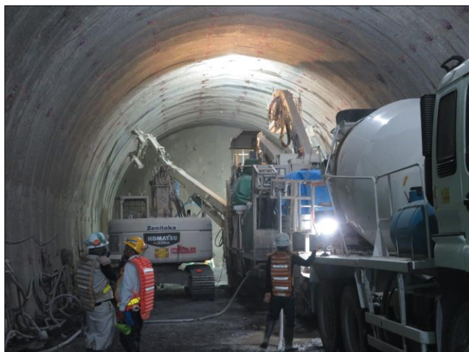
トンネル内での作業の様子
