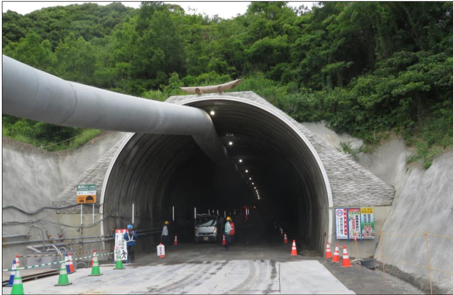
安全パトロールを実施したトンネル工事現場（坑口付近）
