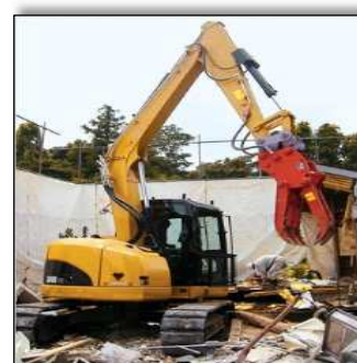
解体用つかみ機の例 （写真提供：キャタピラー ジャパン株式会社）
