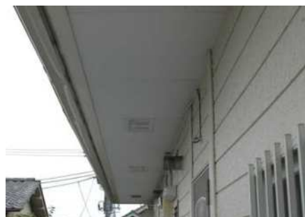
【軒天】 石綿含有けい酸カルシウム板第1種
