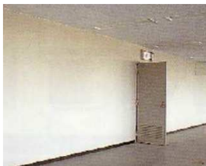
【間仕切り】 石綿含有けい酸カルシウム板第1種
