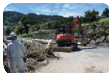
大規模地滑り災害復旧工事現場
