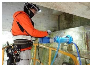
コア抜き調査
