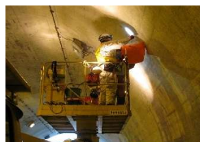
トンネル点検
