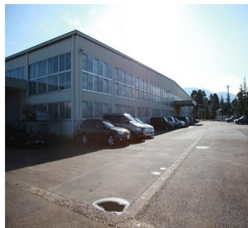
井波工場外観
