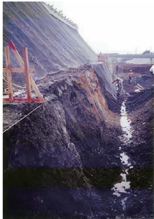
法面での金網張付け作業の状況
