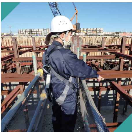
▲ 建設現場での安全確認
