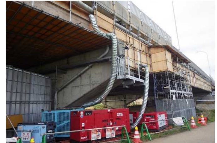
コンプレッサーを使用した空調設備
