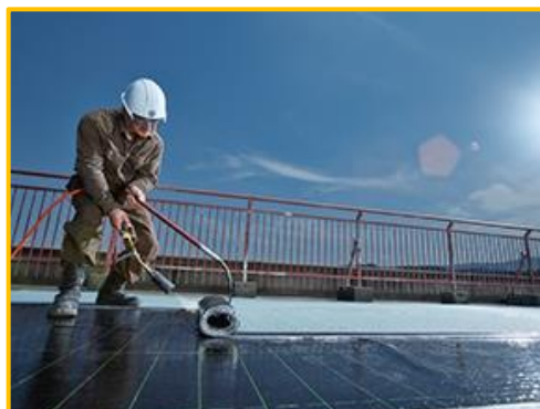
防水工事作業
