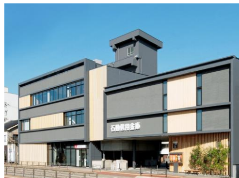
建築工事現場完成写真
