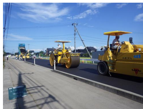
舗装工事現場写真
