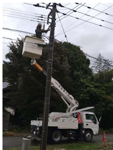
① 外線工事
