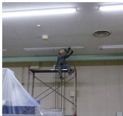
② 内線工事
