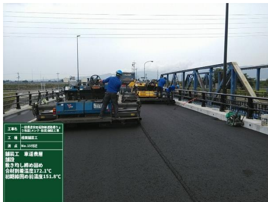
舗装工事 作業風景
