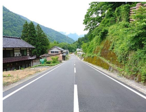
舗装工事 完成
