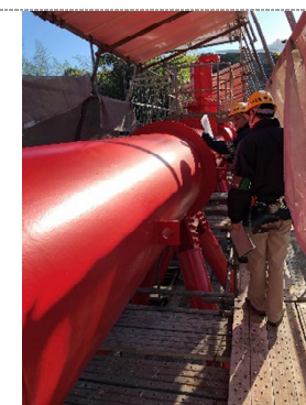
土木工事現場(橋梁塗装)
