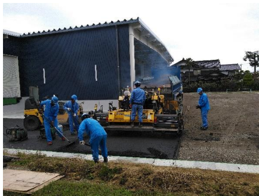
舗装工事 作業風景
