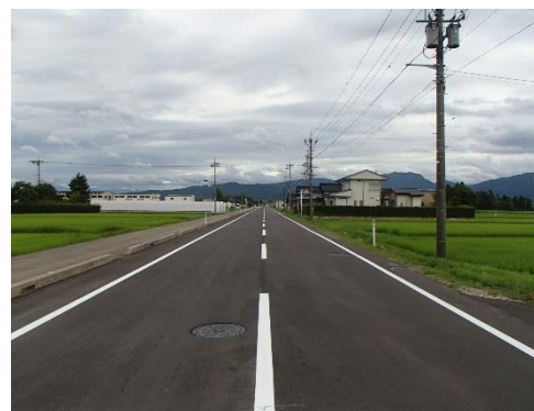
舗装工事 完成
