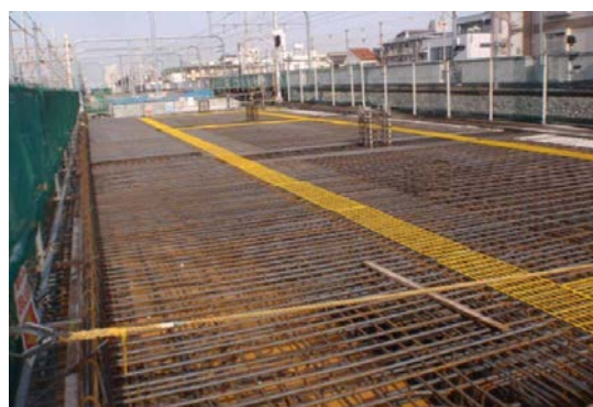
行き先までの通路がわかるように、OKマットを黄色に塗装して鉄筋上の通路とした
