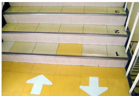
階段に通行区分と、事故が起こりやすい最後の3段にカウントダウンを表示して注意を喚起しています
