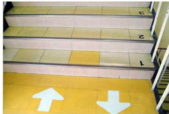
階段に通行区分と、事故が起こりやすい最後の3段にカウントダウンを表示して注意を喚起しています
