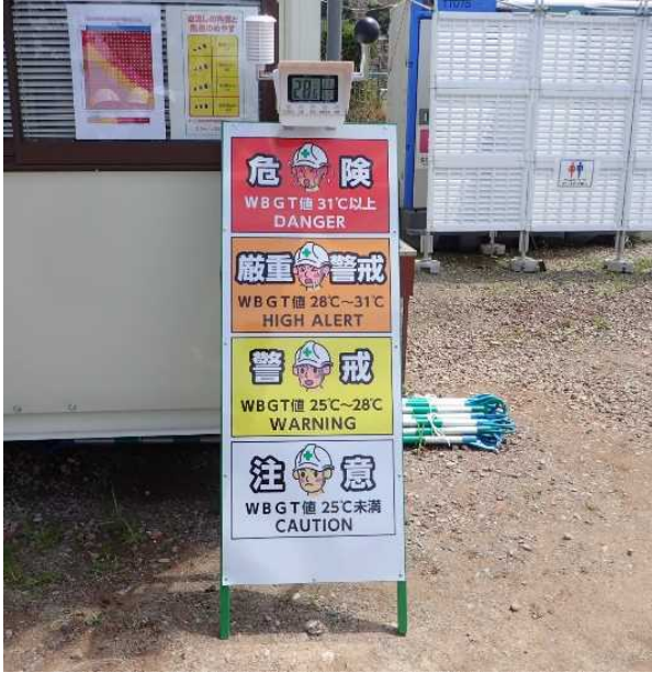
戸田建設(株) 史跡鳥取城跡中ノ御門等復元工事 (その2) WBGT 測定器と熱中症の発症リスク表を現場の見やすい箇所に設置し、すぐに確認できる対策を取っている。
