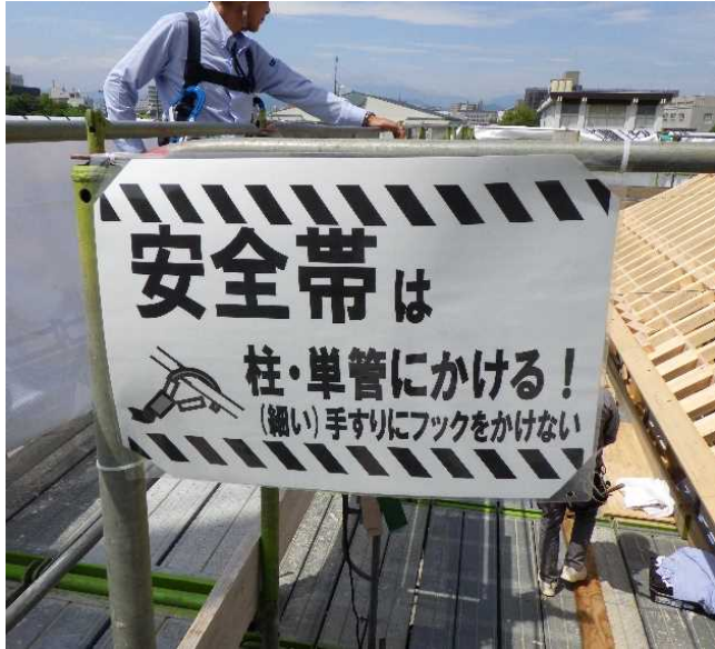
戸田建設(株) 史跡鳥取城跡中ノ御門等復元工事 (その2) 安全帯の使用について、取付設備の強度を考慮し、取付方法を具体的に指示している。
