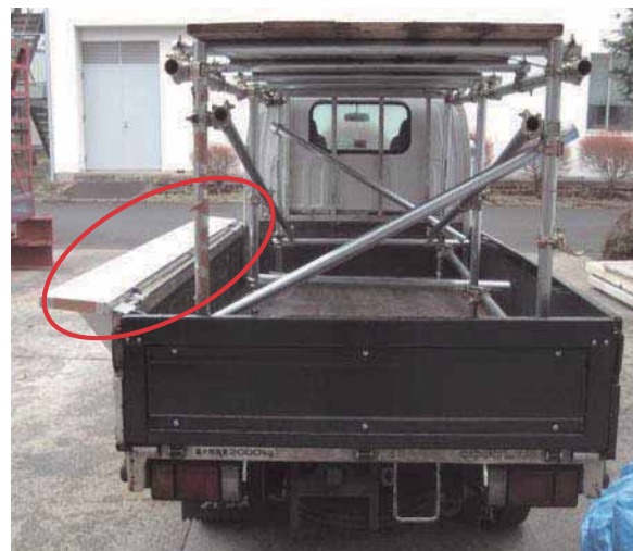
図 3-6 作業床をあおりに取り付けた状態
