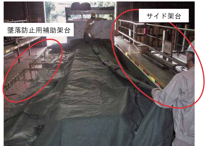
図 4-22 シート掛け作業風景
