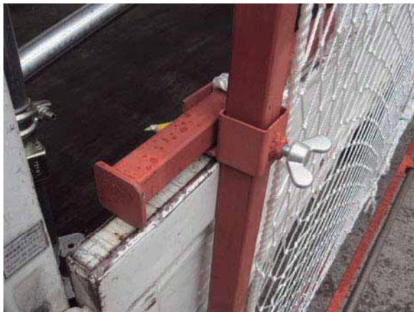
図 3-12 墜落防止柵を荷の横に移動し、両サイドのネジで高さ調整を行っている状態
