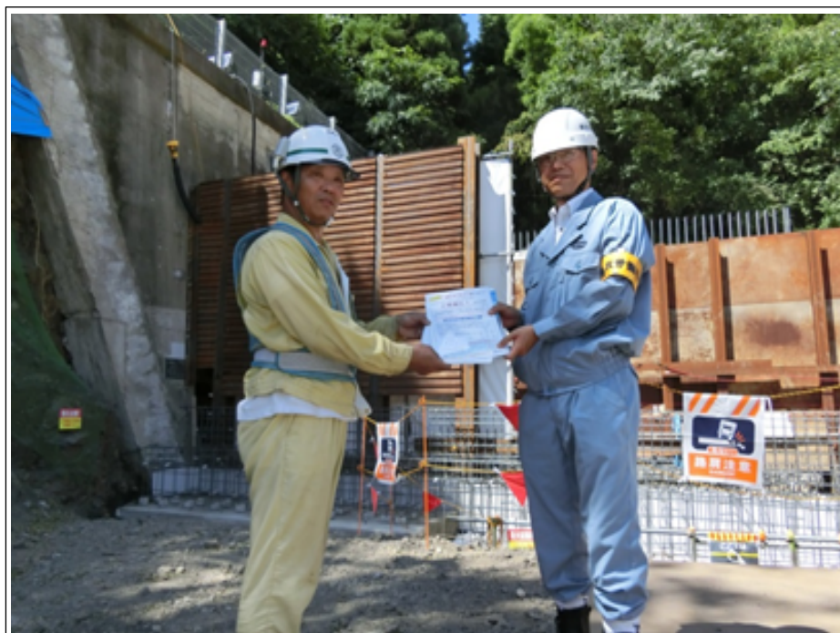
復旧工事の安全対策について要請行う丸山鳥取労働局長
