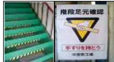
階段の滑り止めシールと注意喚起
