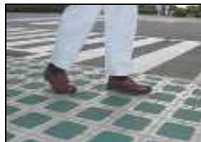
屋外通路の滑り止めシール
