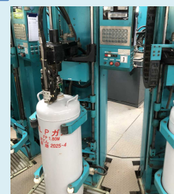
【LPガスボンベの充てん所の自動化】
