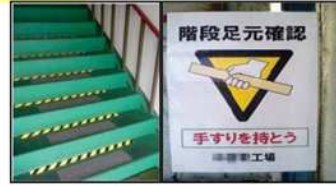
階段の滑止めシールと注意喚起
